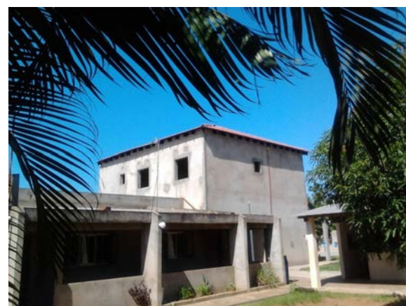
Maputo – Casa Ndangwini. La casa in muratura sta crescendo
